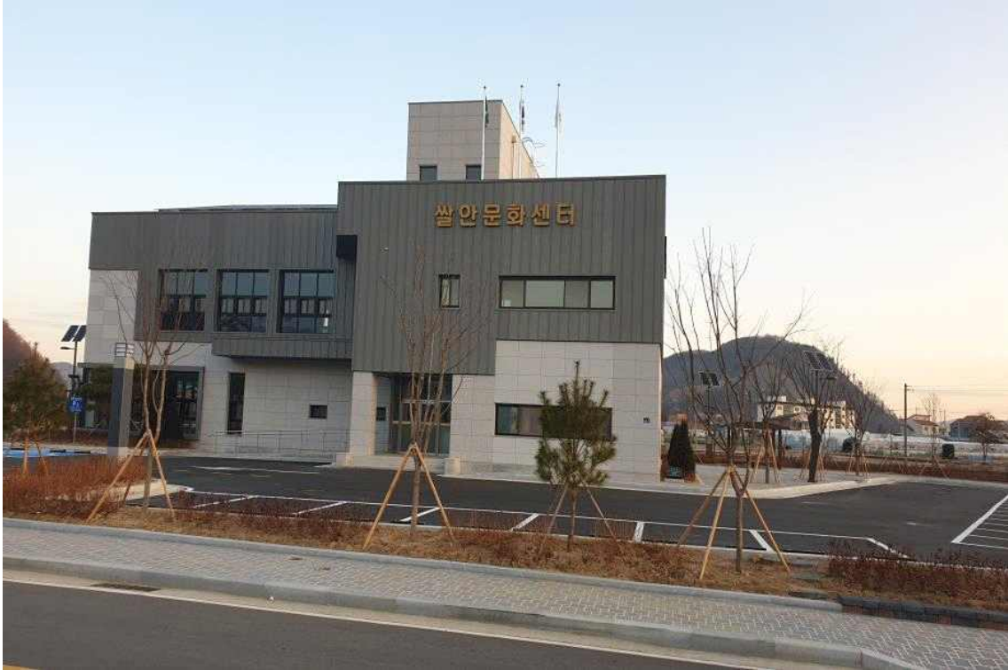
○ 청주 미원면 건강증진센터 전경(미원면 농촌중심지활성화사업)
